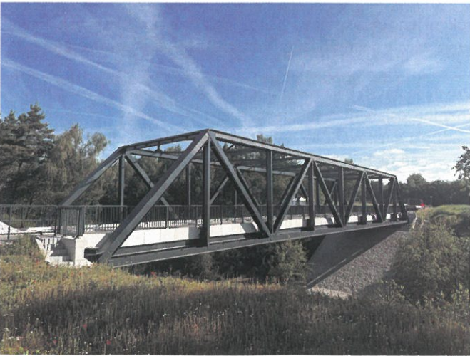
obr. 1 Dokončená lávka v Chotíkově
