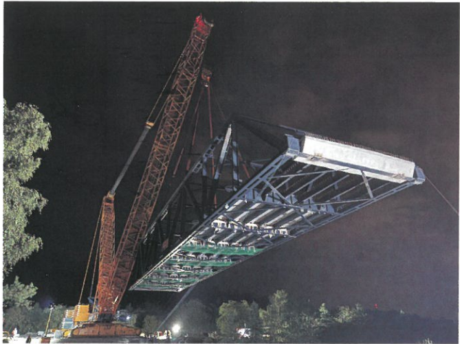
obr. 11 Noční usazení mostu pomocí jeřábu
