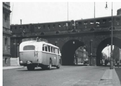
▲ Původní přemostění Křížíkovy ulice v Karlíně před rekonstrukcí, 1954
