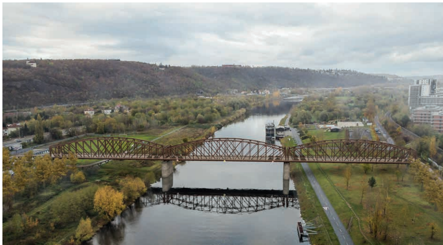
△ Přesun stávajícího mostu do Modřan-Chuchle pod jezem
