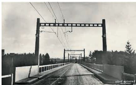
^ Bechyňský most se sdílenou mostovkou pro železnici a silniční dopravu
