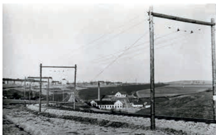
^ Dřevěné brány nesoucí trolejové vedení a elektrárna
