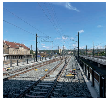
^ Atypické trakční vedení na estakádách (v pozadí ještě původní výpravní budova)
