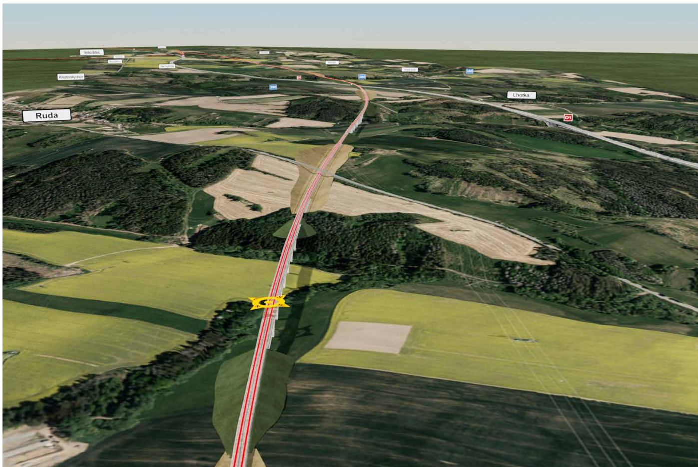
^ Průchod VRT přes poměrně široký migrační koridor velkých savců za Jablonořem. Prostup je umožněn dlouhými mostními estakádami.
