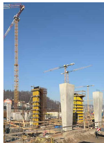
▲ Sloupy spodní stavby nové lávky pro pěší
