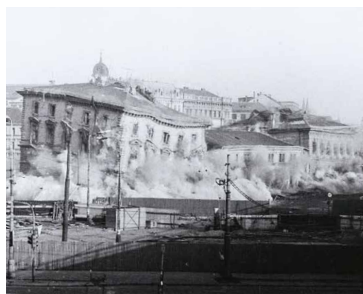
^ Demolice těšnovského nádraží 16. března 1985
