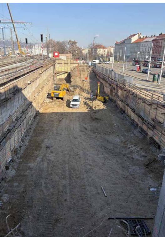
▲ Jáma pro budovu nového Severního křídla je již hotova
