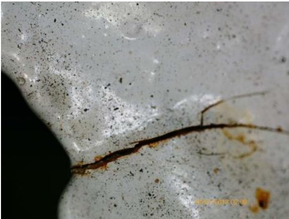
Detail – únavová trhlina
