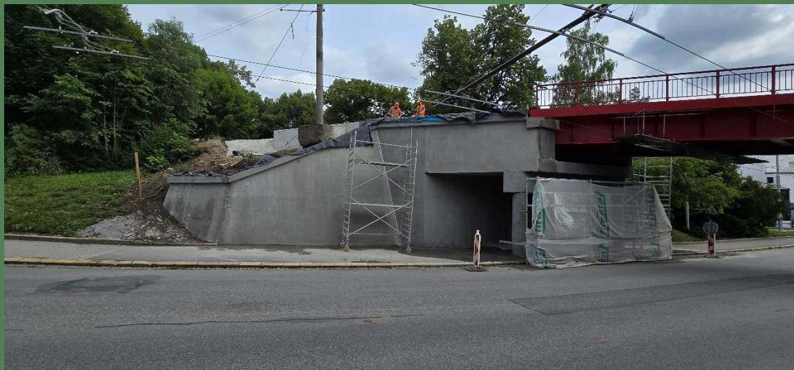
Sanace betonových ploch
