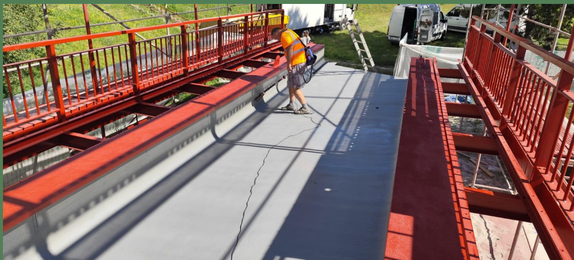
SVI ocelové konstrukce
