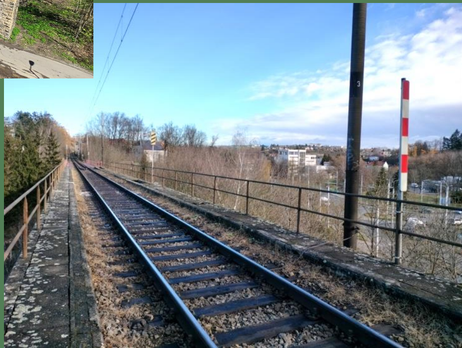
Stávající stav monolitické římsy
