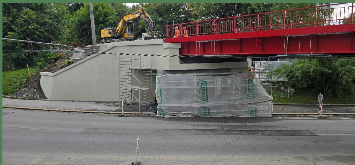
Sanace betonových ploch
