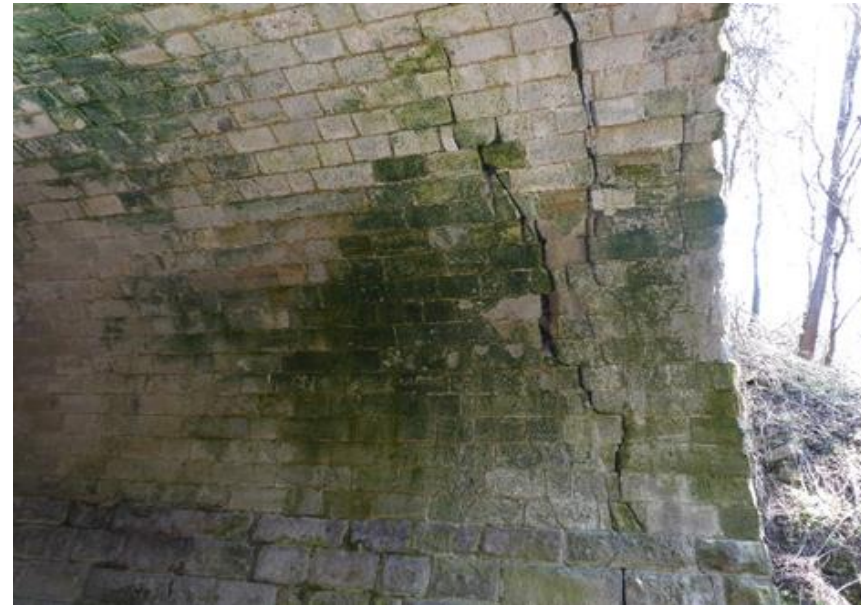
Obr. 10: Pozdĺžne trhliny v mieste styku s bočnou stienkou.
