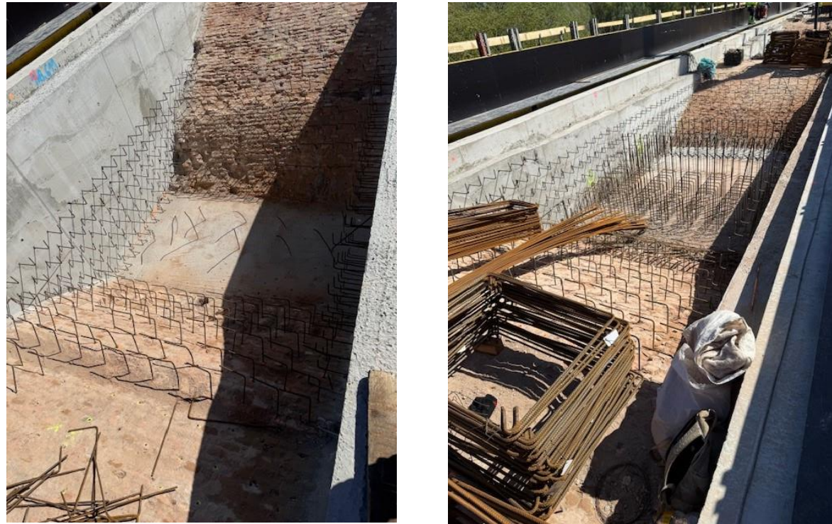
Obr. 18: Rekonštrukcia mosta – zosilnenie klenieb a bočných stienok.
