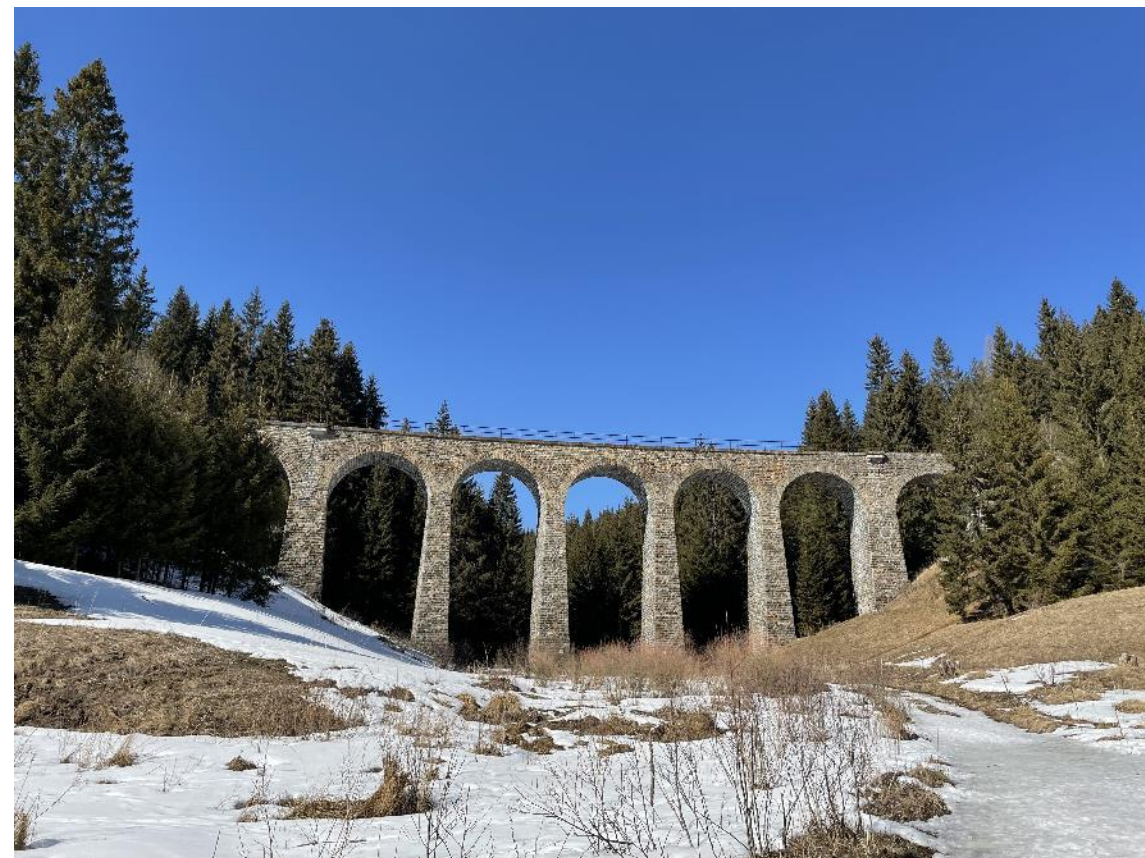
Obr. 20: Pohľad na Chmarošský viadukt.
