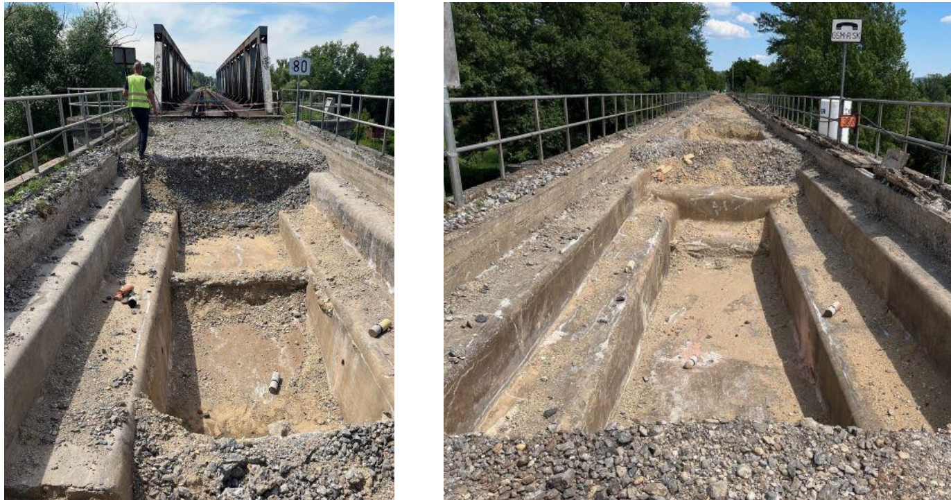
Obr. 17: Rekonštrukcia mosta – odťaženie štrkového lôžka.
