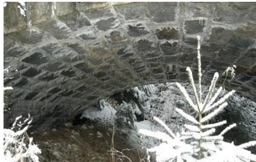
Obr. 12: Zatečenie klenby mosta s výluhmi cementového kameňa škárovania.
