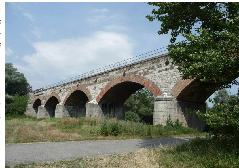
Obr. 15: Pohľad na klenbovú časť mosta.
