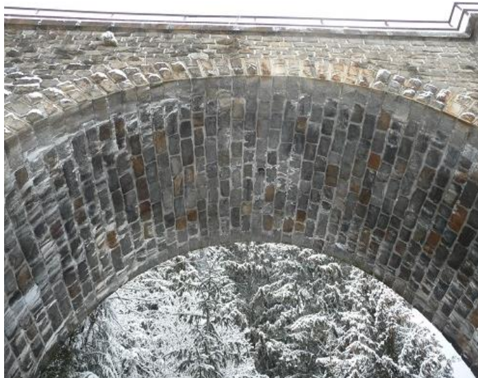
Obr. 12: Zatečenie klenby mosta s výluhmi cementového kameňa škárovania.
