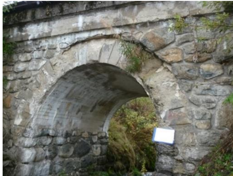
Obr. 11: Vychýlenie a zrútenie bočnej stienky.
