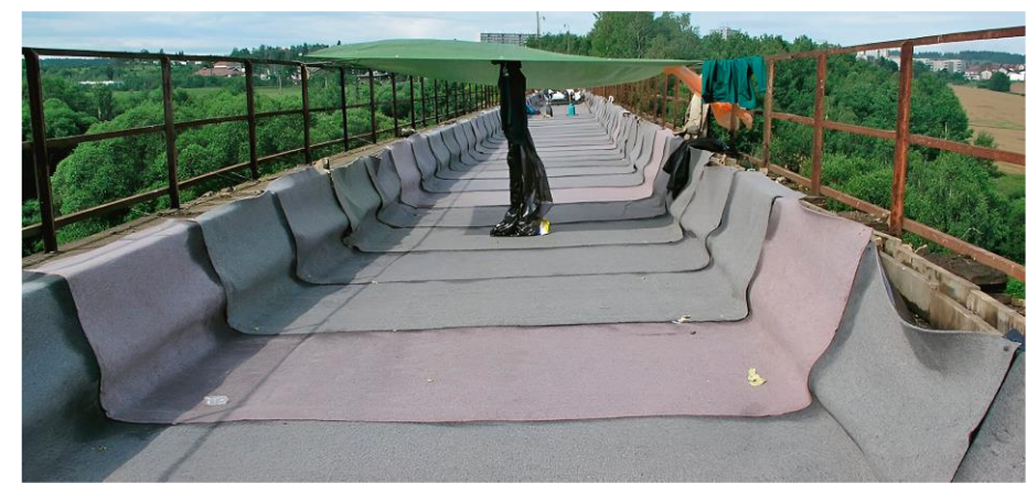
Nová hydroizolace a sanace NK v roce 2005
