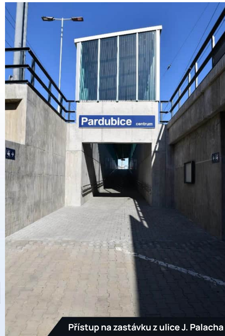
Přístup na zastávku Pardubice centrum z ulice J. Palacha
