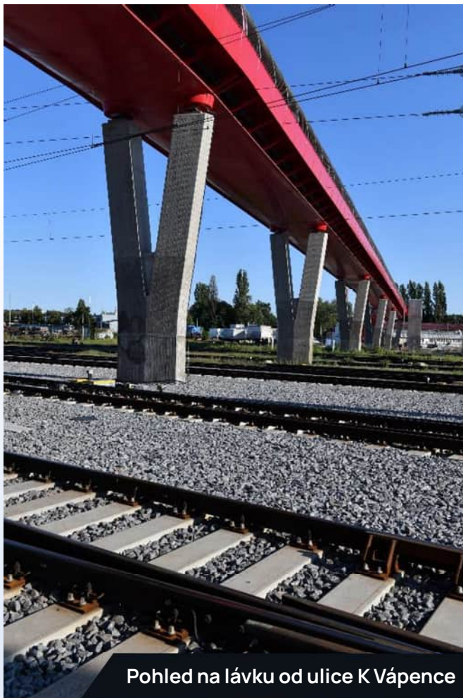
Lávka přes ulici K Vápence
