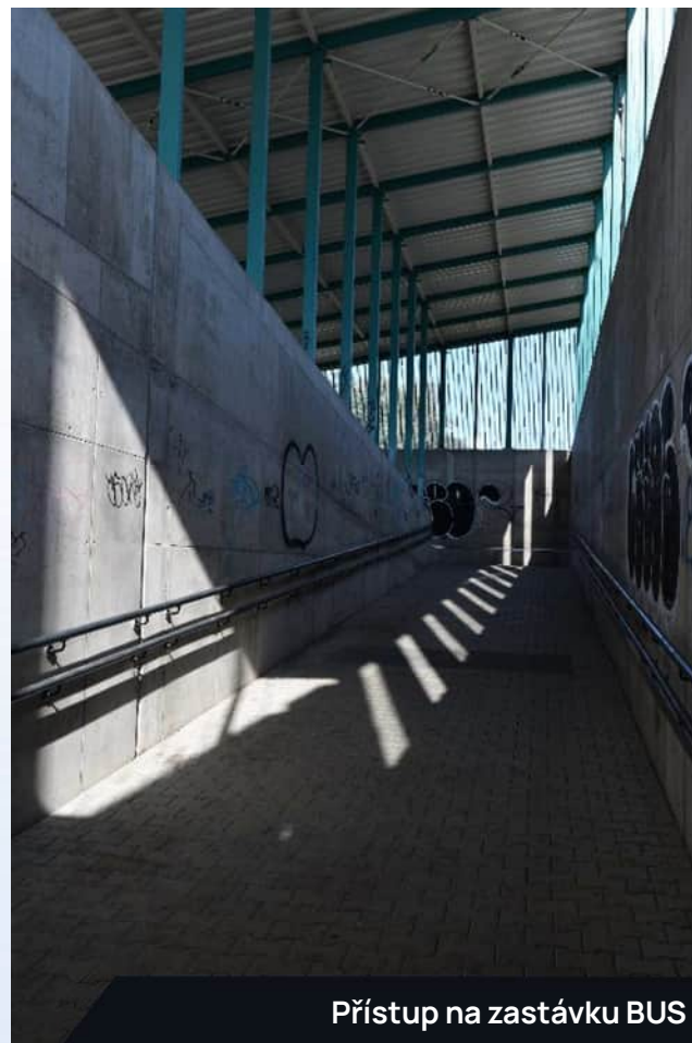
Přístup na zastávku z ulice J. Palacha
