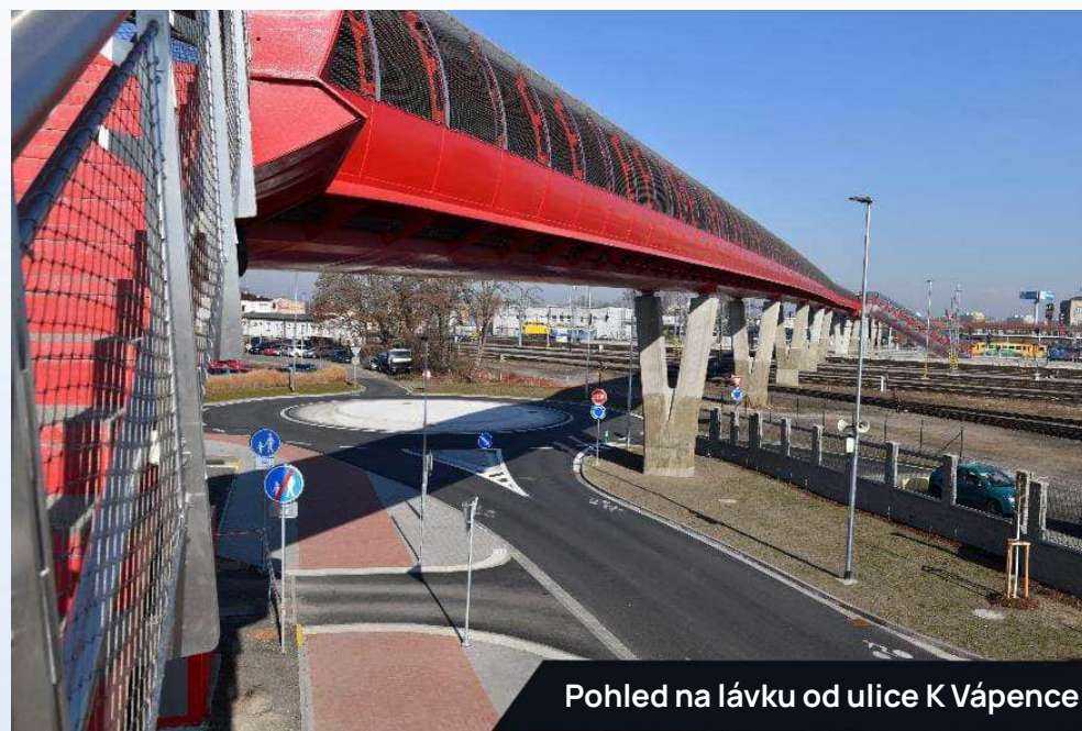
Přístup na lávku z ulice K Vápence
