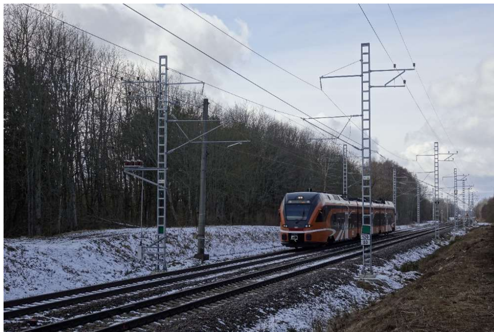
Mezistaniční úsek Lagedi - Raasiku
