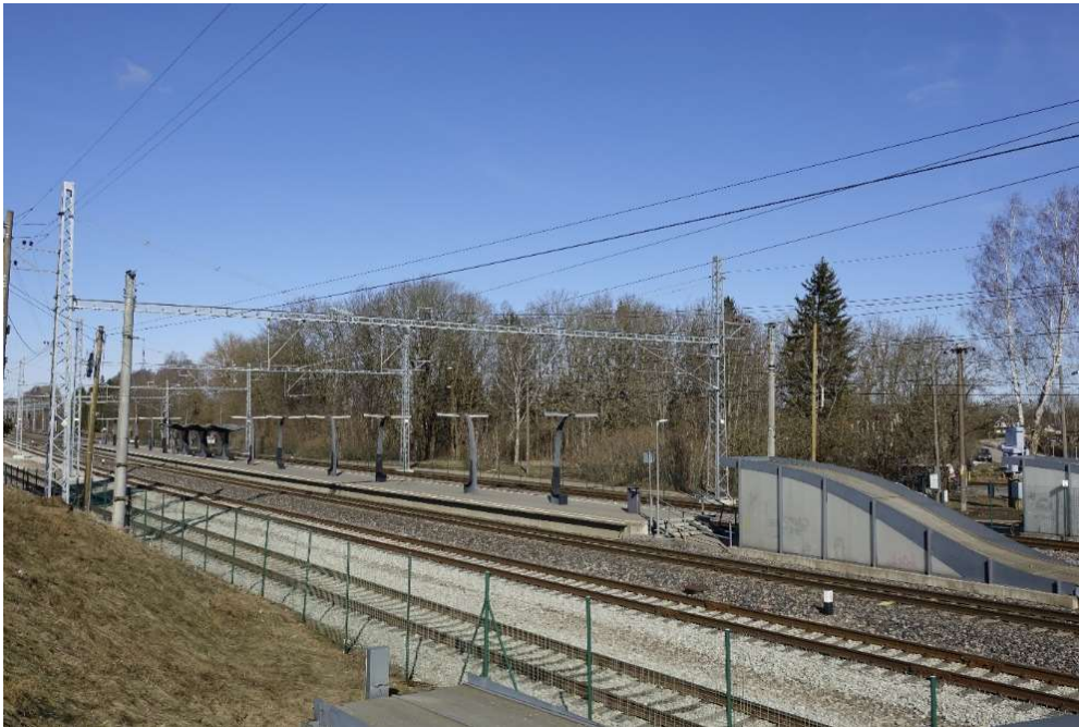
Železniční stanice Lagedi
