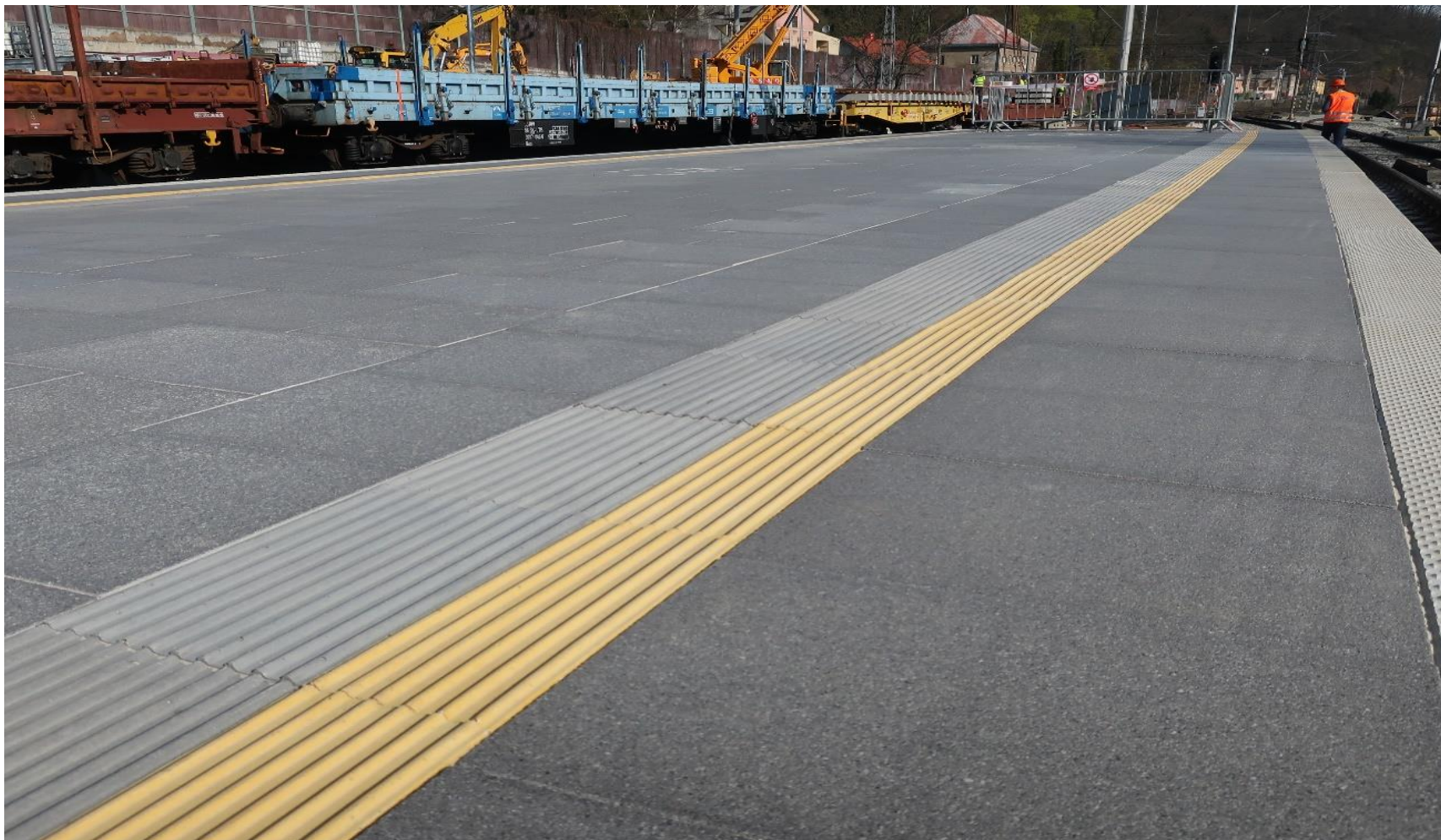
Typová dlažba dle VL Ž8 10.1, realizace žst. Roztoky u Prahy
