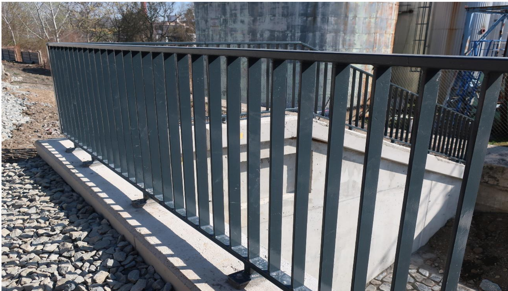
Typové zábradlí dle VL Ž12 1, realizace žst. Roztoky u Prahy
