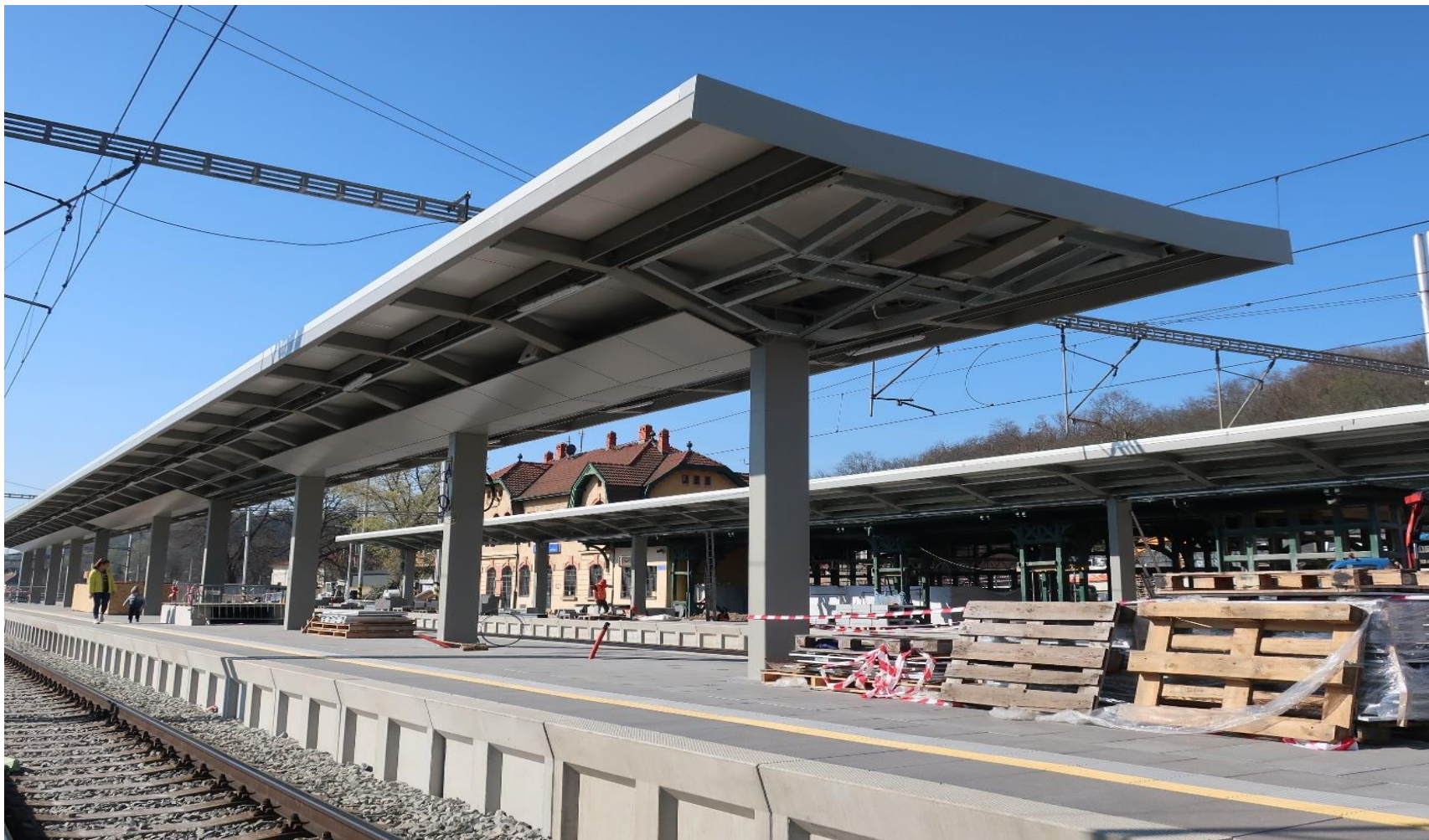
Typové zastřešení dle VL Ž13 1, realizace žst. Roztoky u Prahy
